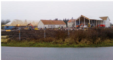
Byggeriet er i fuld gang.
