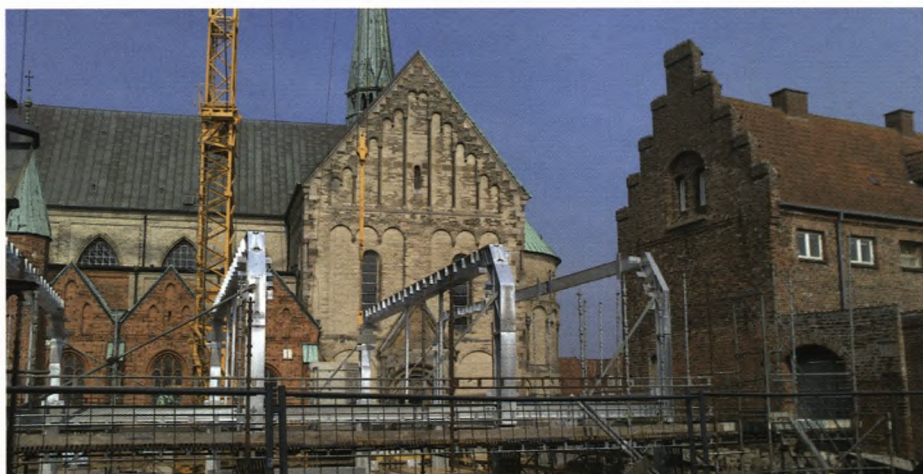
Byggeriet set fra Sønderportsgade midt i marts.
