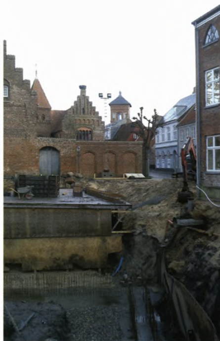
Den fredede ruin beskyttes under byggeriet. I baggrunden ses Vandtårnet, som har fået en ærefuld bevaringspris fra Esbjerg Byfond.
