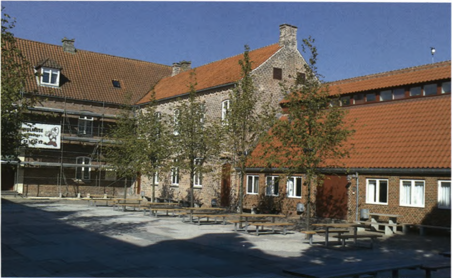
Der blev ordnet vinduer i hovedbygningen.
