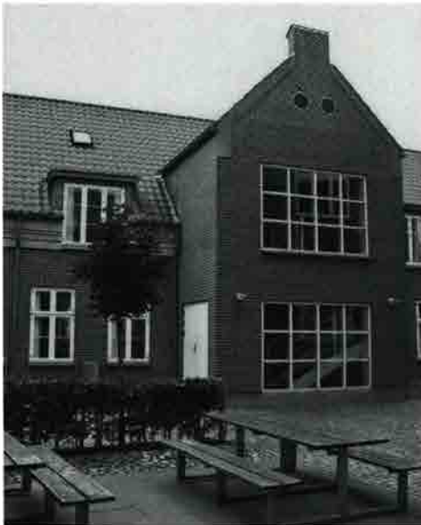
Fig. 7. Fritliggende bygning i Gravsgade, bagside.
