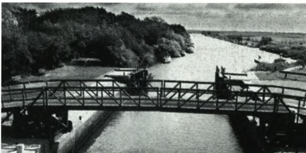
I alt slags vejr er der smukt ved Kammerslusen. Den lille bro i forgrunden er en bilbro, hvor broklapperne åbner sig, hvis det er nødvendigt. Broen forbinder nord og syd, men dog kun for køretøjer op til to ton.
