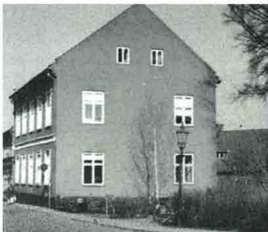
Ribe Dommerkontor er i forfald, men vil blive renoveret umiddelbart efter påske.
