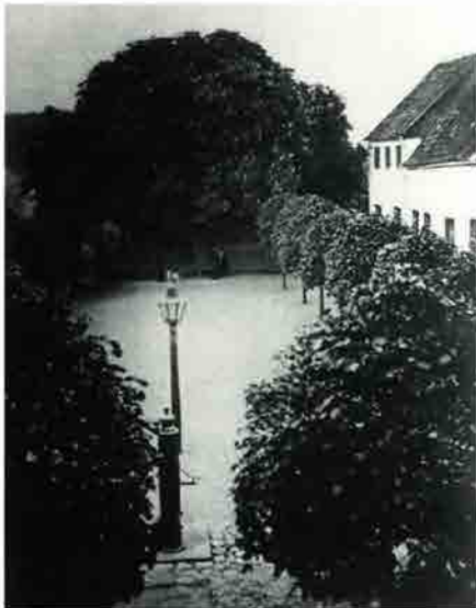
Det ældste billede af skolegården, taget fra Hovedbygningen 1865. I forgrunden vandpumpen og den gamle tranlampe. Til højre Puggård, og i baggrunden kastanietræet og stakittet ud mod Puggårdsgade.
