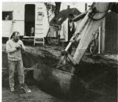
Fig.1. De øverste uinteressante lag fjernes maskinelt. Stig Jensen overvåger afgravningen.
